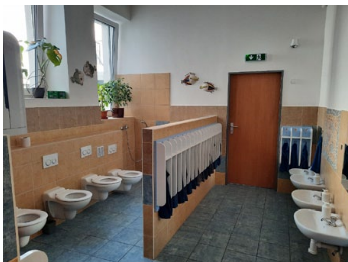
Koupelna po realizaci
