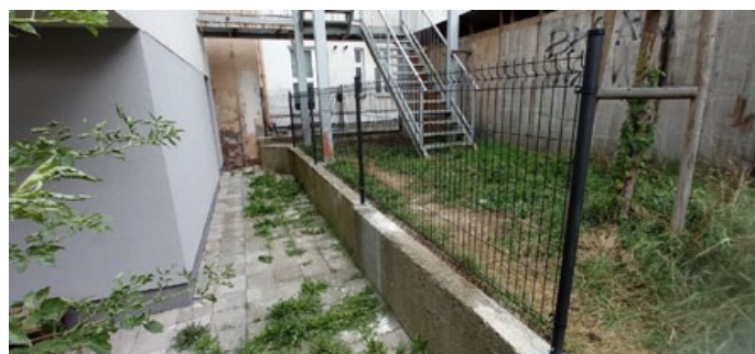
Upravené venkovní prostory po realizaci
