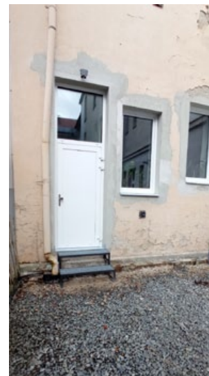
Venkovní prostory po realizaci
